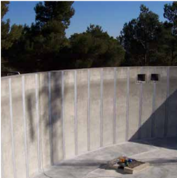
Réservoir Dupail, France: 900 m of Sikadur-Combiflex® SG Tapes.
